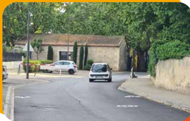
Réfection de l'enrobé rue du Labadou
