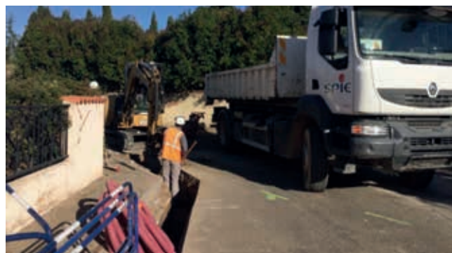
Rue de la Tour : rénovation de l'éclairage public avec le remplacement des câbles souterrains.
