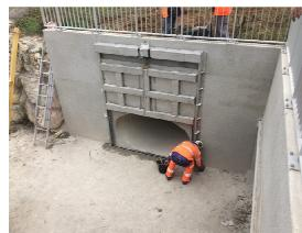
Pose d'une vanne martelière pour obturer en cas d'inondation la canalisation ovoïde posée dans la zone Euro 2000 dans le cadre des travaux liés à l'extension de la ligne T1 du TCSP.
